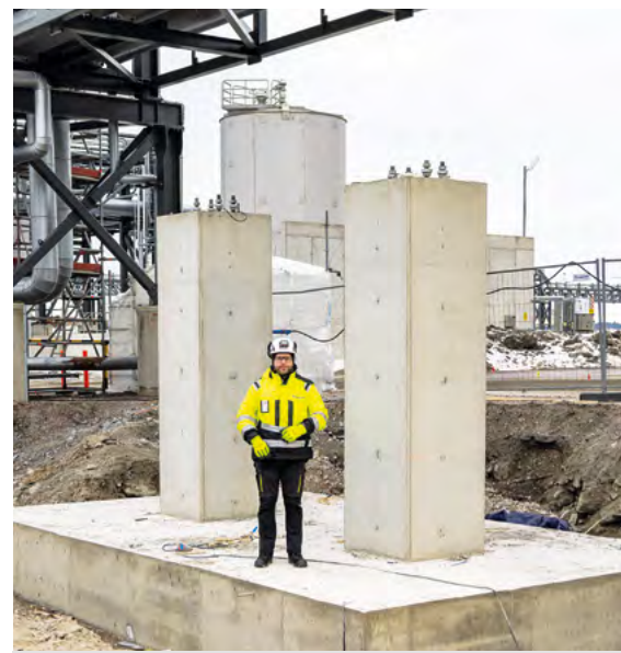
Jykevät ovat teollisuusrakennuksen perustukset. Mannekiinina Veolian hankkeessa Rakennusliike U. Lipsanen Oy:n työnjohtajana työskentelevä Jarno Honkanen.
