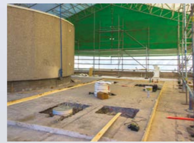
Pasilan virastokeskuksen A-siiven katto on suojattu sääsuojin. Kattoa on avattu ja tarkkuutta vaativat läpiviennit on tehty uusien ilmanvaihtokonehuoneiden asennusta varten.
