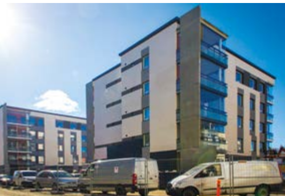
Lemminkäinen Rakennus Oy:n rakentamaan Asunto Oy Hopeatäplän kahteen viisikerroksiseen pistetaloon tulee 34 asuinhuoneistoa, yhteensä 2190 asuinmääriteltä.
